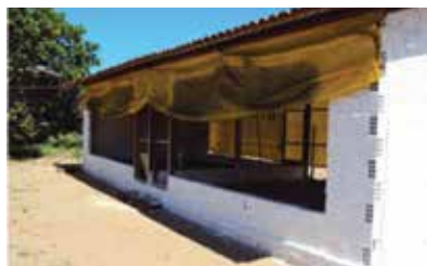
Fig. 11. Aviário de alvenaria com telhas de barro.
