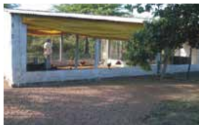
Fig. 12. Aviário de alvenaria com telhas de fibrocimento.
