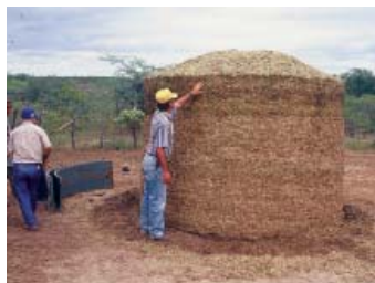
Silo cincho em construção
