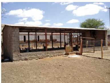
Figura 11 - Aviário em alvenaria
