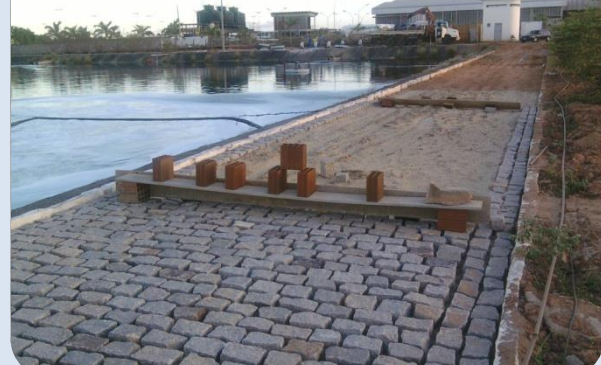
Pavimentação das Lagoas
