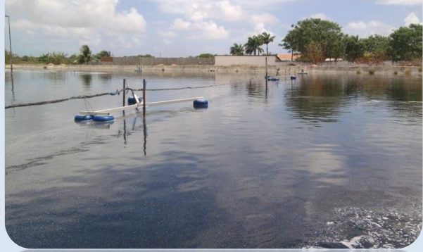
Lagoa Aerada Aeróbia
