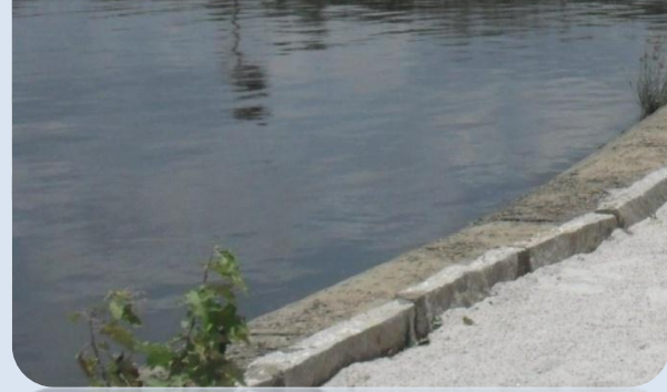
Lagoa Aerada Facultativa
