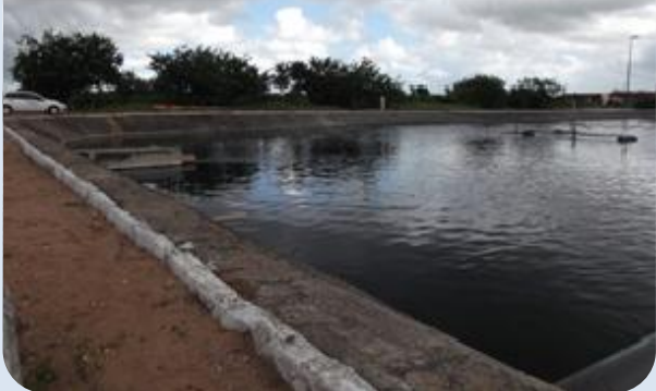
Taludes e Lagoa capinados
