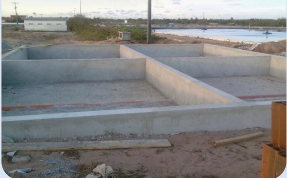
Leito de Secagem em Construção
