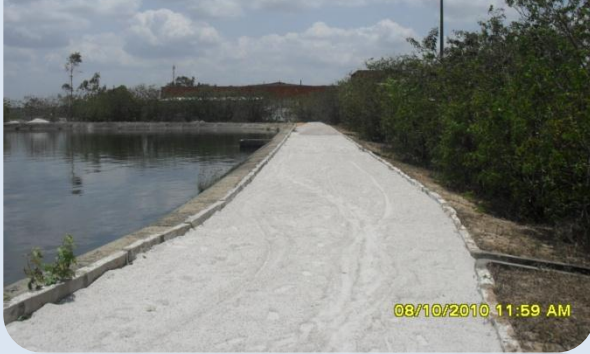
Lagoa Aerada Facultativa
